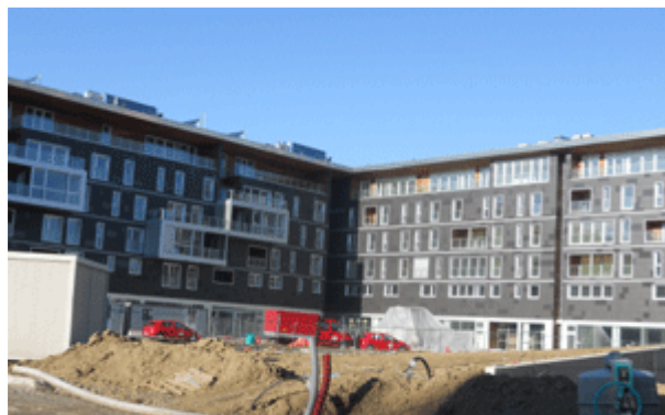
Uno degli edifici realizzati dalla Stu Pasubio
